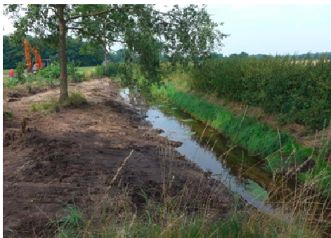
Umgestaltungsabschnitt während der Bauphase
